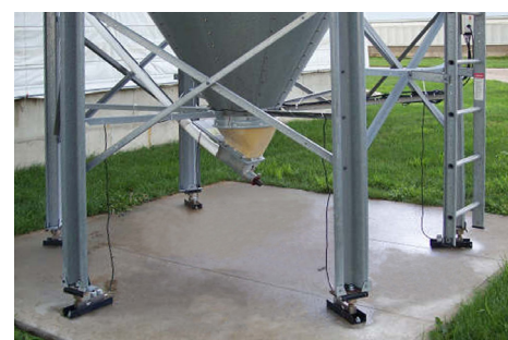
Tensometry pod silos o maksymalnym obciążeniu do 4500 kg (10 000 funtów) na nogę silosu paszowego.
