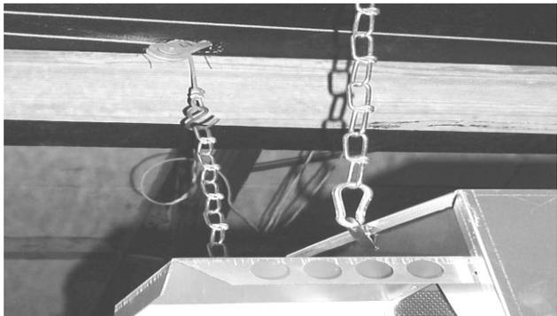
**Nota:** No monte este calentador directamente debajo de conductores o cables de electricidad expuestos.
