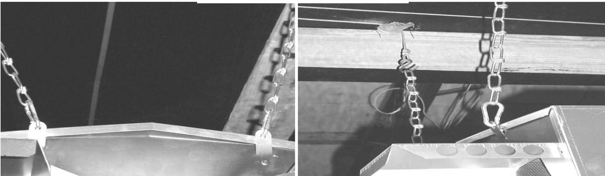
**REMARQUE:** Ne montez pas ce chauffage directement sous le câblage électrique exposé ou dissimulé sous conduit.
