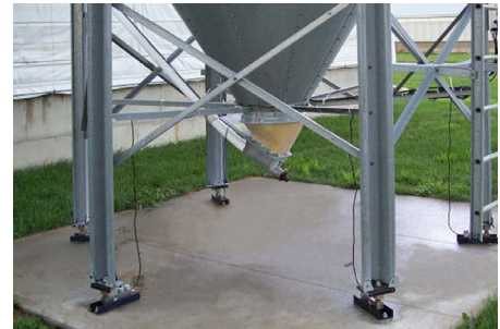
Weegcellen verwerken tot 4500 kg (10.000 pond) per silopoot.
